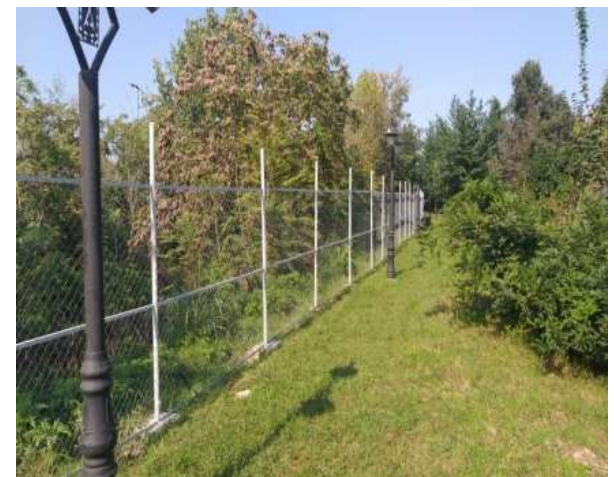
عکس بعد از اجرا
