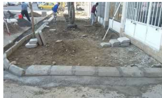
عکس بعد از اجرا
