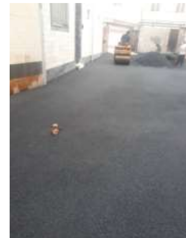
عکس بعد از اجرا
