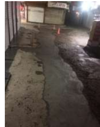
عکس بعد از اجرا
