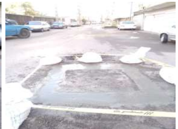
عکس بعد از اجرا
