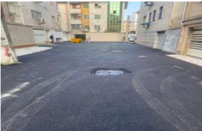
عکس بعد از اجرا
