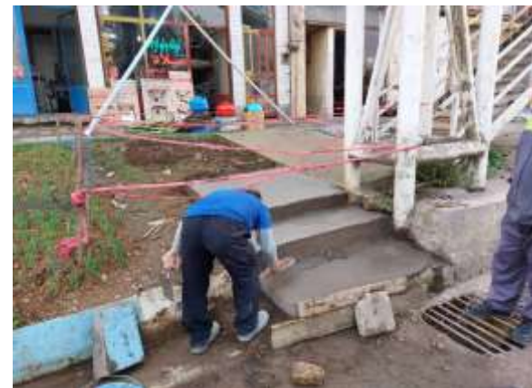
عکس بعد از اجرا
