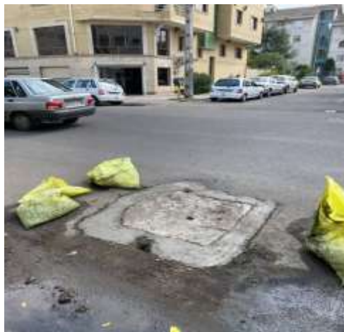
عکس بعد از اجرا
