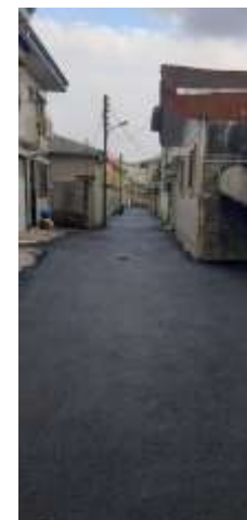
عکس بعد از اجرا
