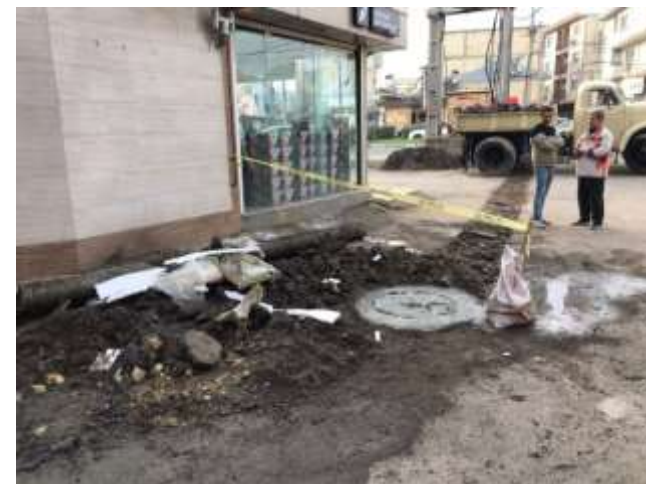
عکس بعد از اجرا
