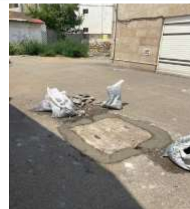
عکس بعد از اجرا
