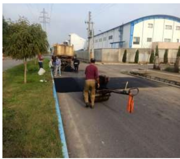
عکس بعد از اجرا
