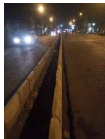
عکس بعد از اجرا
