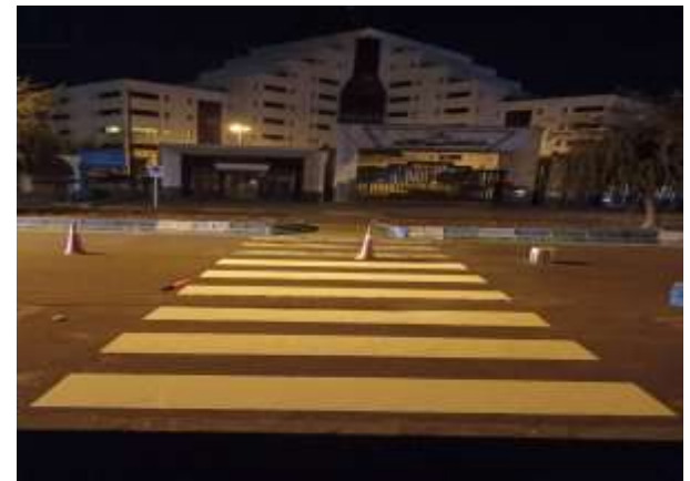
عکس بعد از اجرا
