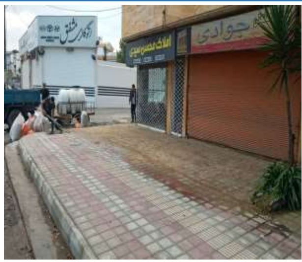
عکس بعد از اجرا
