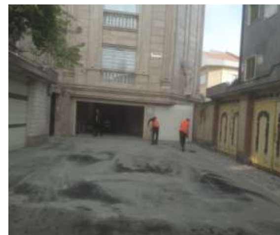
عکس بعد از اجرا
