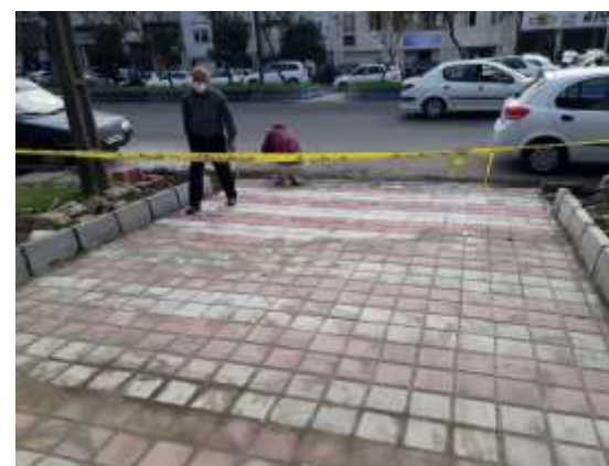
عکس بعد از اجرا
