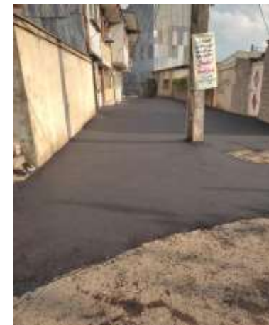
عکس بعد از اجرا
