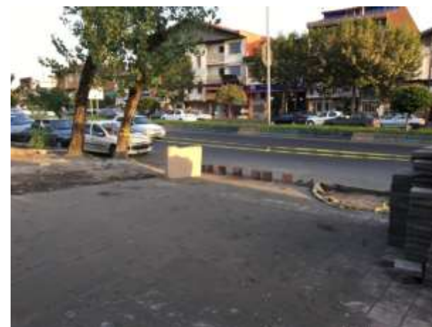
عکس بعد از اجرا
