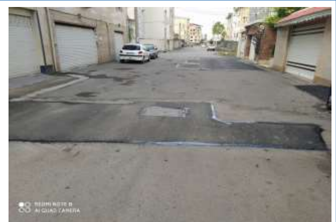
عکس بعد از اجرا
