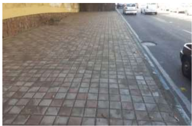
عکس بعد از اجرا
