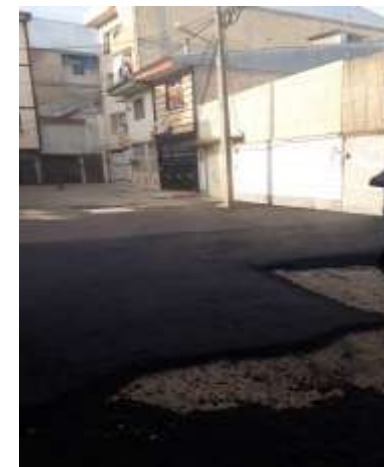
عکس بعد از اجرا
