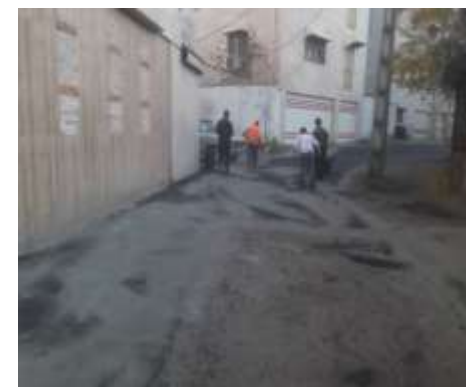
عکس بعد از اجرا
